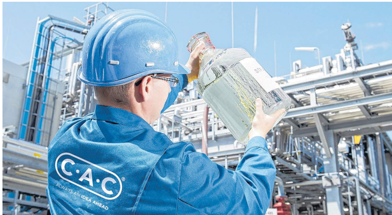
Die wichtigste Prozessstufe in der Herstellungskette setzte der Chemnitzer Chemieanlagenbau in einer zur TU Bergakademie Freiberg gehörenden Demonstrationsanlage um.
